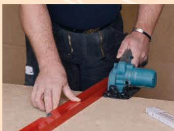
Zuschnitt der Lehmbauplatten mit der Stichsäge
