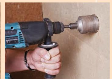
Bohren von Löchern für die Elektroinstallation
